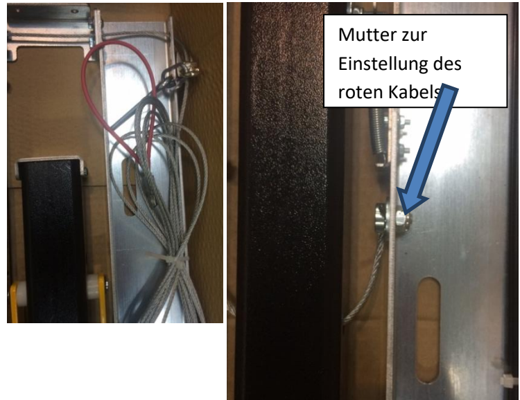
(Detailansicht rotes Kabel)
